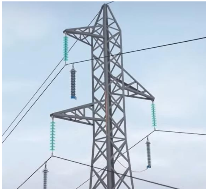
Slika 27. Načini ugradnje linijskih odvodnika prenapona
