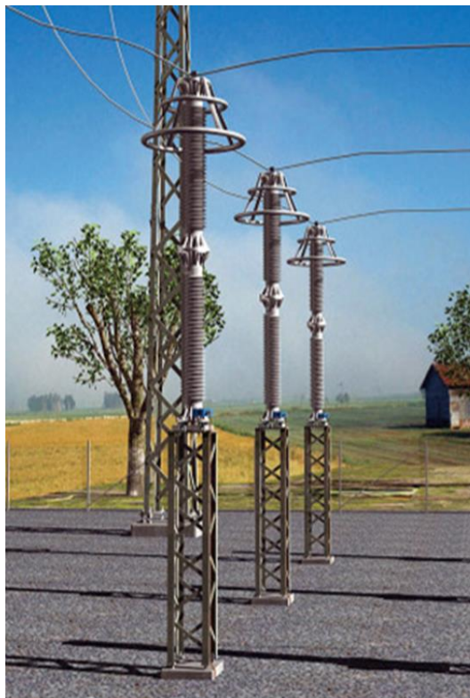
Slika 28. Načini ugradnje odvodnika prenapona u postrojenju
